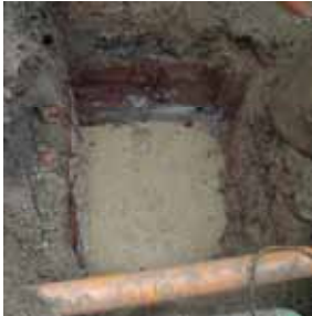
1.) Baugrube vorbereiten und Kies/Sandunterlage herstellen
