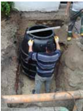
3.) Fettabscheider ausrichten
