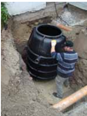
2.) Fettabscheider einsetzen
