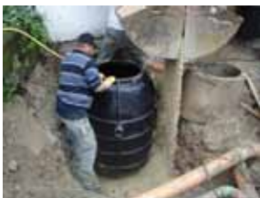
4.) Fettabscheider schrittweise abwechselnd mit Wasser befüllen (ca. 20 cm) dann Kiesschüttung (ca. 20 cm) herstellen und verdichten usw. Darauf achten, dass der Fettabscheider in Wasser steht.
