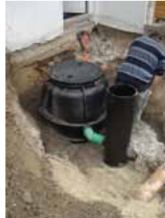
5.) Probennahmeschacht setzen und anschließen
