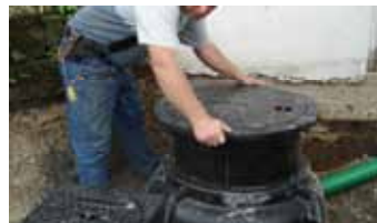
8a.) TOPATEC Teleskopschachtaufsatz einsetzen (bis Klasse B125)
