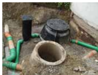
6.) Abwasserrohr wasserdicht anschließen
